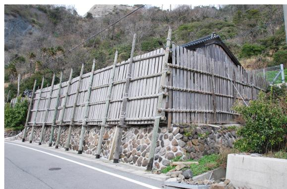
写真（右）：強風対策の板囲い 隠岐島後・蔵田集落（2008）
